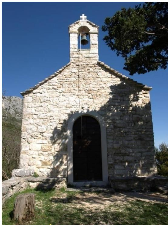
Okvir crkve je pravokutnog tlocrta i sazidan je od masivnih četvrtastih blokova kamena vapnenca koji se naslanjaju na tu prirodnu stijenu. Vrata na pročelju crkve su na luk. Po sredini apside nalazi se također mali uski prozor sveden na luk. Na južnom zidu je prozor naknadno povećan. Mali zvonik na jedno okno oborio je grom, tako da je danas postavljeno provizorno željezno postolje za zvono.
