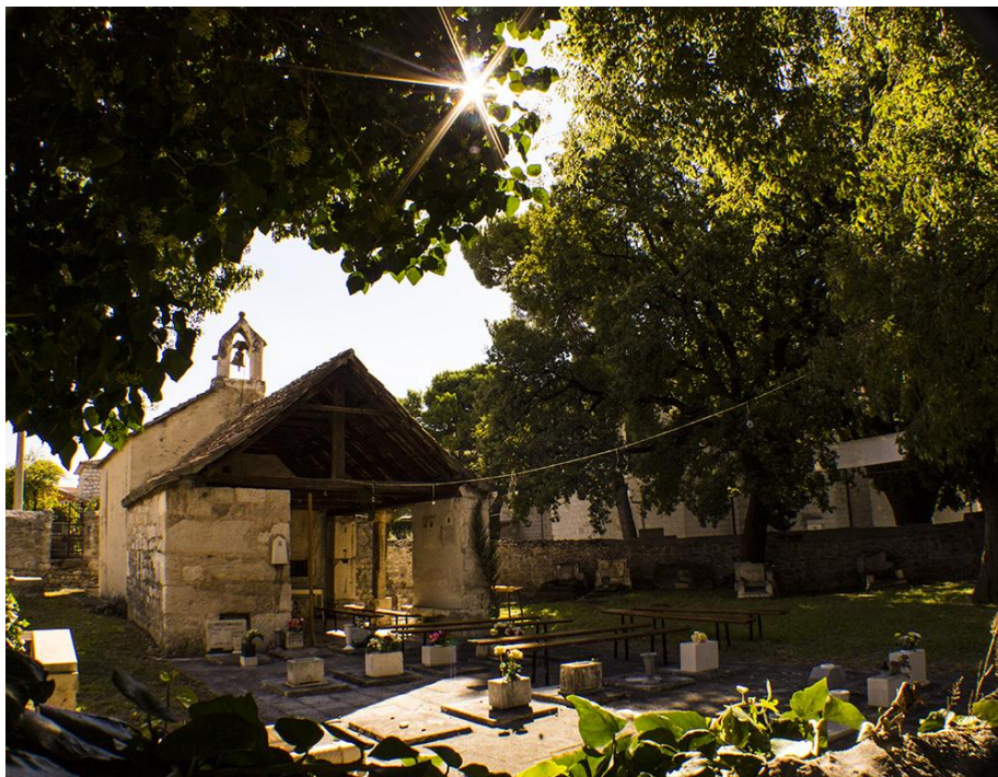
Slika 22. Crkva sv. Kuzme i Damjana, pogled sa sjeverozapada
