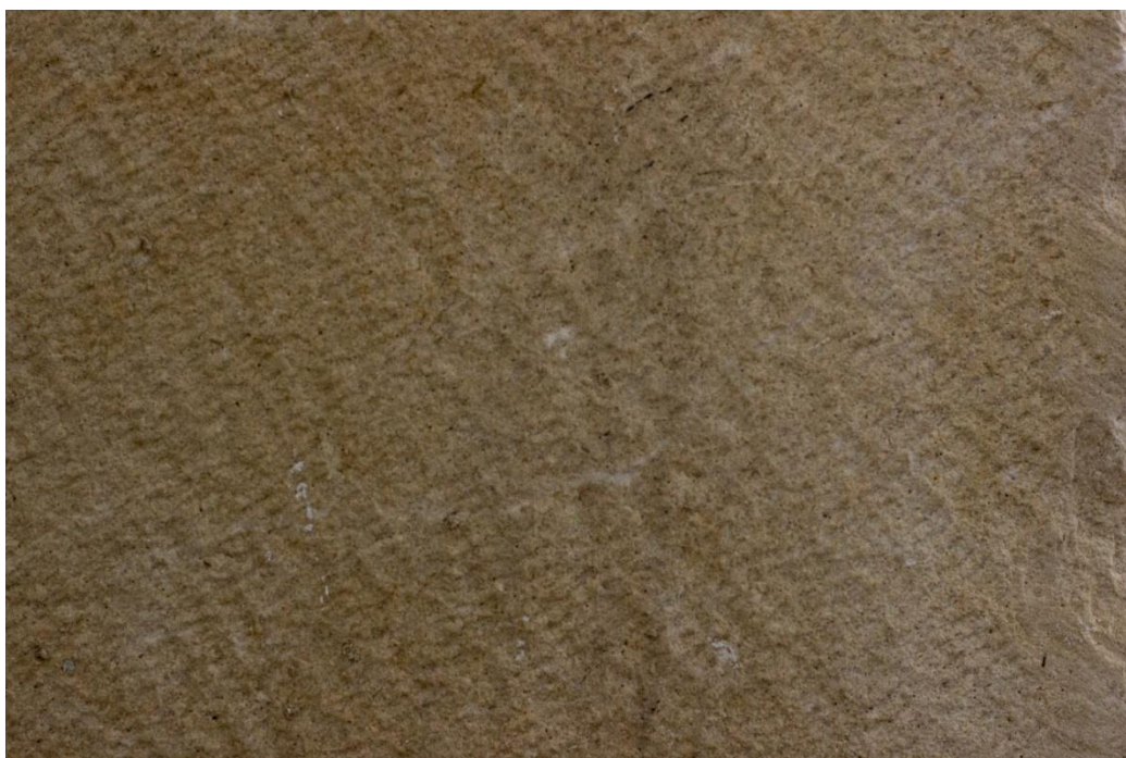
Sl. 121. Tragovi martelina s rubom (špigulom) napravljenim ravnim dlijetom, Postolje s natpisom u čast božice Venere, sredina 2. st., Arheološki muzej Naron, fotografija: Vedran Kundić
