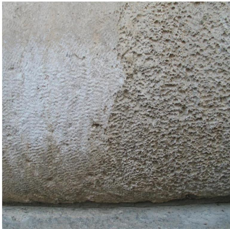
Sl. 99. Detalj površine na kojoj je sačuvan izvorni trag alata-marteline i gradine i detalj površine koja je erodirana kišom, Friz, Peristil,
