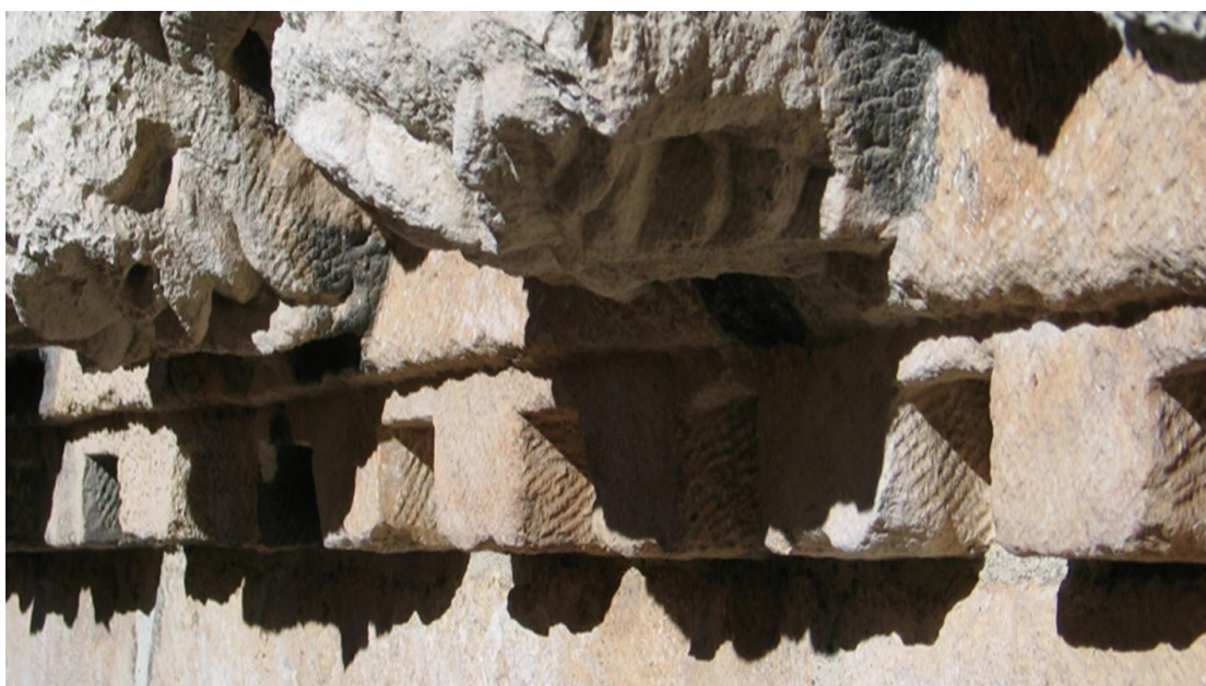
Sl. 98. Tragovi gradine su vidljivi na dentima, Zapadna strana vijenca, Peristil, fotografija. Vinka Marinković
