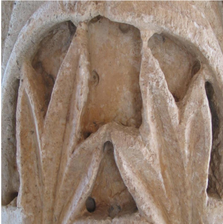
Sl.135. Rupice rađene svrdlom, Detalj akantusovih listova na kapitelu prvog stupa, Peristil, fotografija: Vinka Marinković
