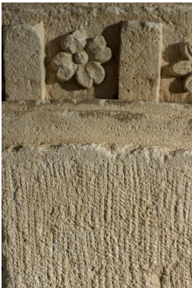
Sl.125. Ukopani tragovi marteline rađeni okomitijim postavljanjem alata, Dio dekoriranog arhitektonskog elementa, 1.-3.st., Arheološki muzej Naron, fotografija: Vedran Kundić
