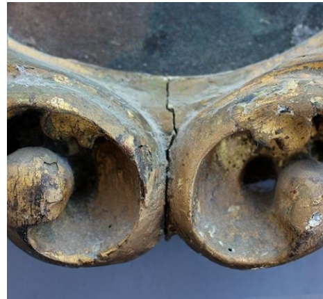
Slika 76 Pukotina u preparaciji na spoju dekorativnih letvica, detalj
