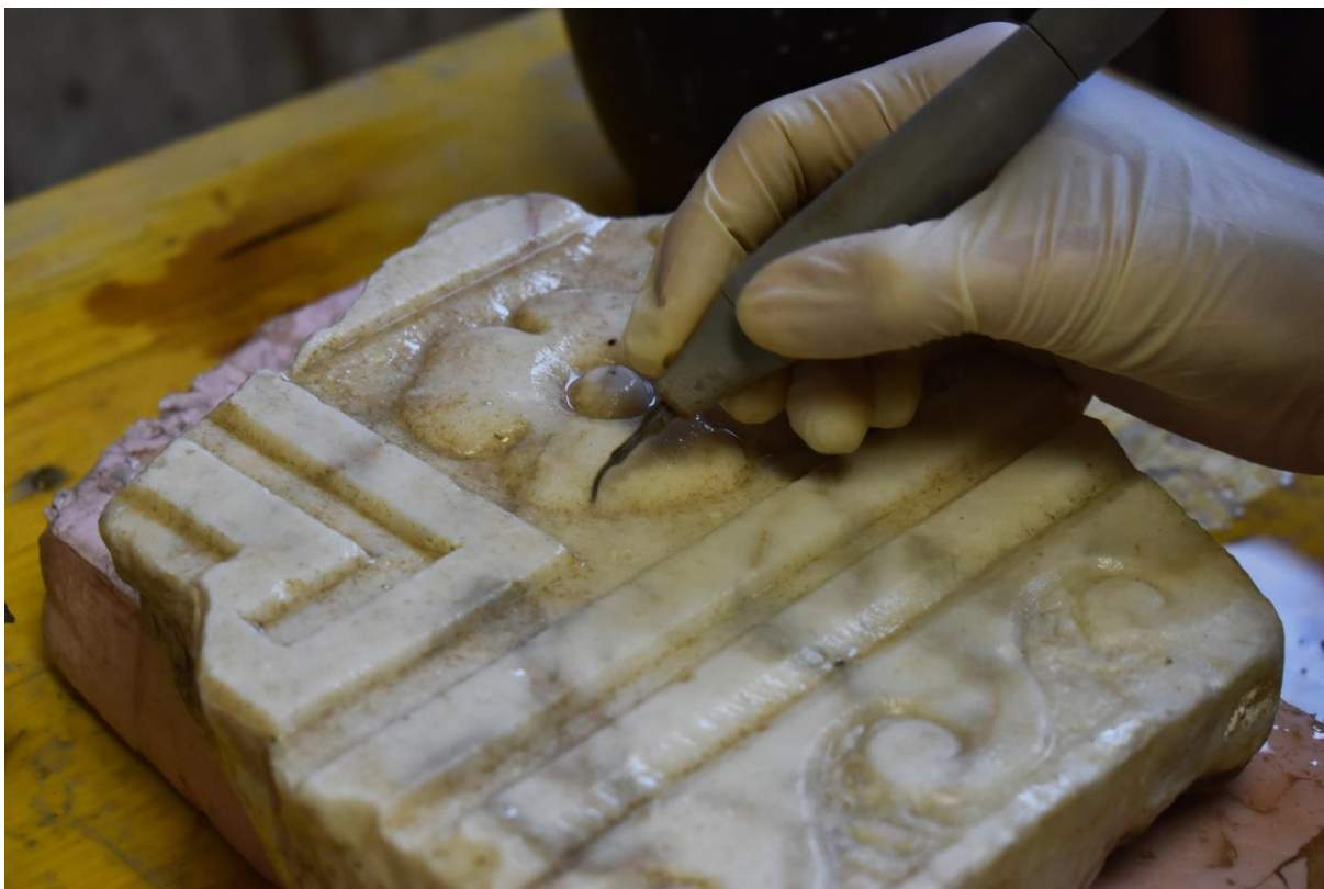
Slika 26: Detalj čišćenja ultrazvučnom iglom (foto: B. Pulić)
