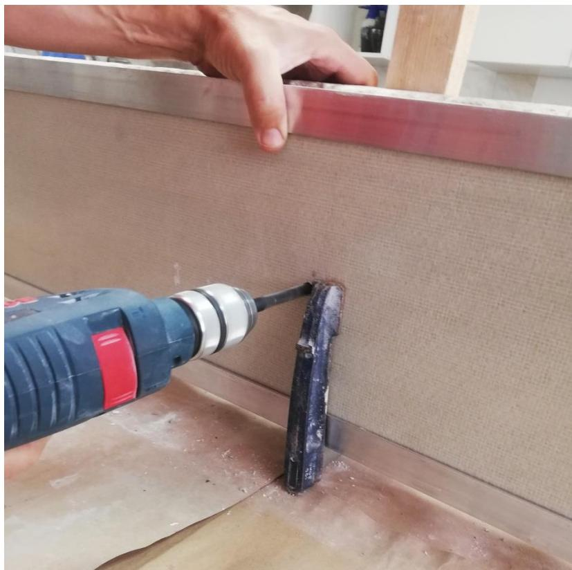
**Slika 57:** Bušenje nosača (foto: A. M. Lučić)
