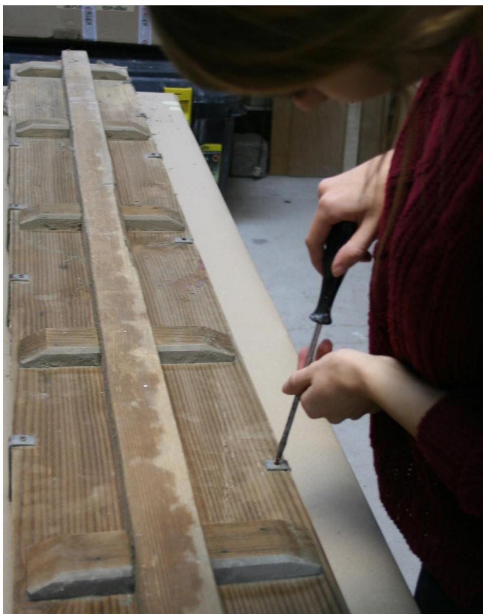
**Slika 15:** Odvajanje drvene nosive konstrukcije od mramorne oplate (foto: B. Pulić)
