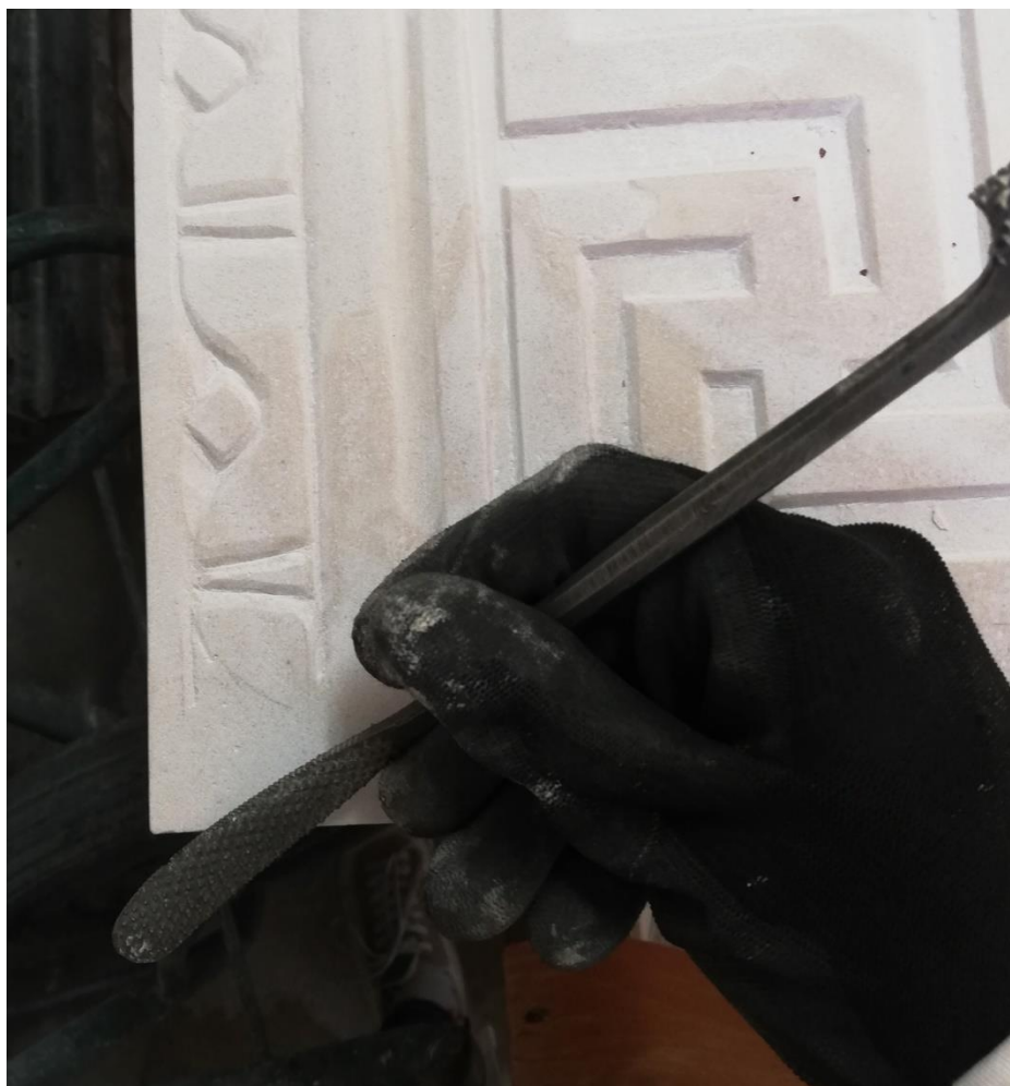
Slika 69: Završna obrada oštarih rubova turpijom za kamen (foto: A. M. Lučić)
