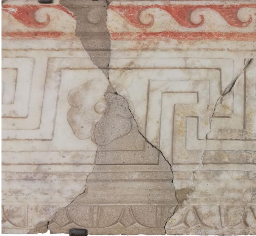
Slika 18: Detalj rekonstrukcije izvedene u portland-cementu (foto: A. M. Lučić)
