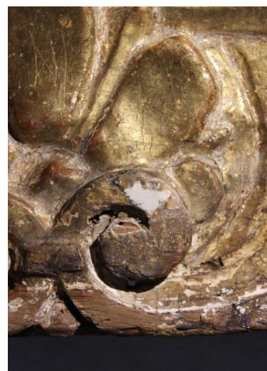
Slika 164: Zona oštećenja nakon obrade kita
