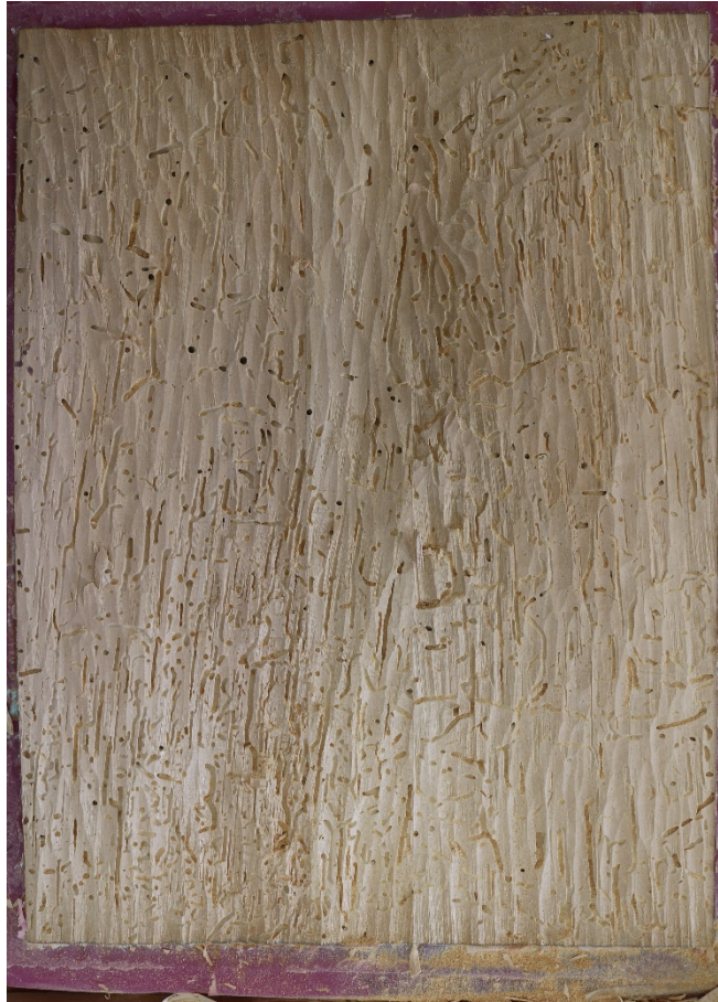
Slika 5 Stupanj izjedenosti drvenog nositelja zamijećen prilikom konz.-rest. zahvata
