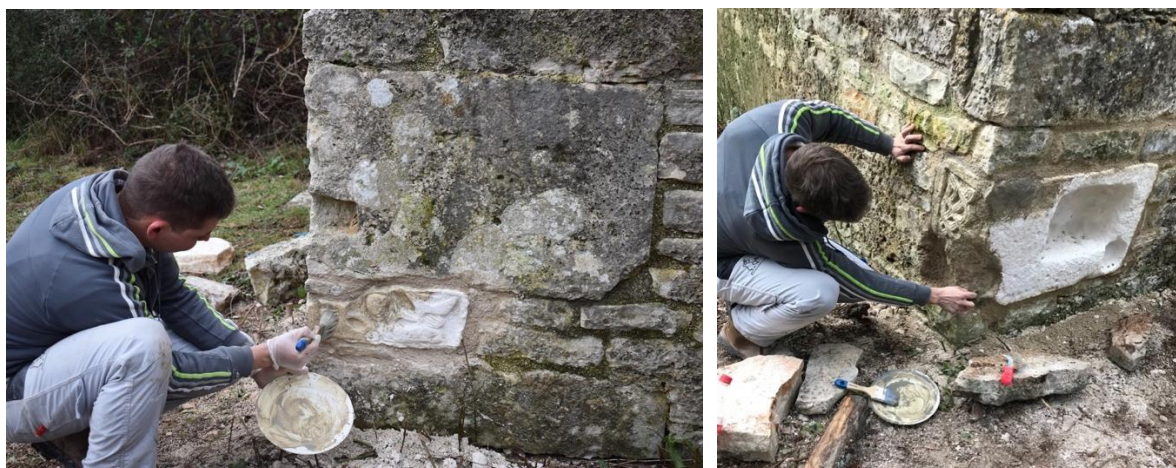
Slika 131, 116. Patiniranje replika, fotografija: Martin Zohil
