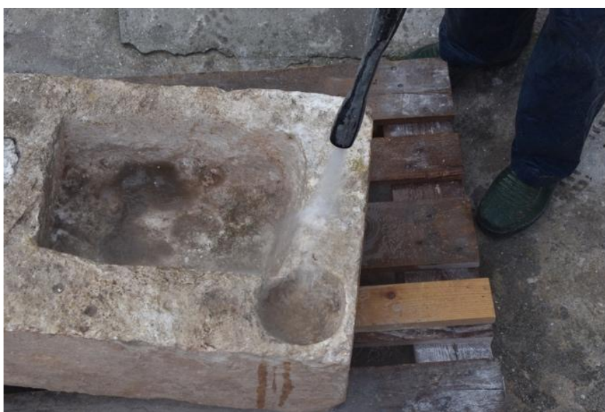
Slika 108, Čišćenje miniwashom, fotografija: Martin Zohil
