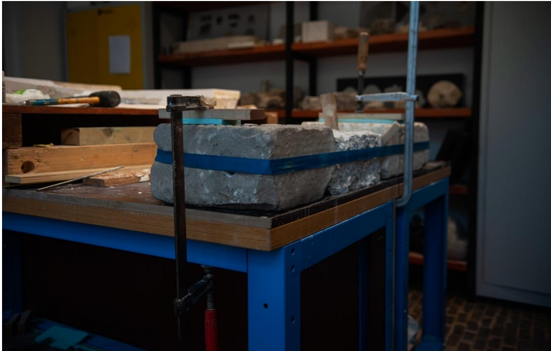
Slika 43 i Slika 44., Fiksiranje pilastra s stegama i trakom s natezačem (autor: Rina Dubravec)
