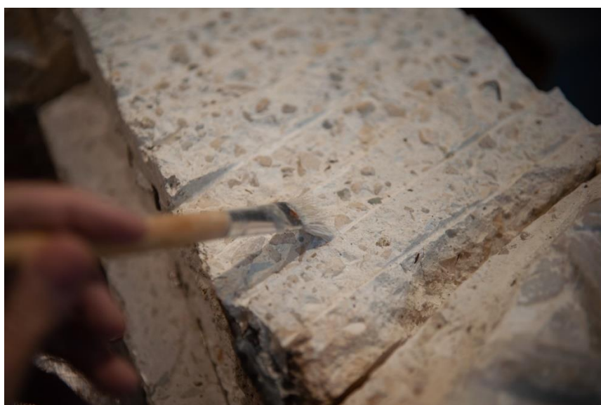
Slika 46 Premazivanje površine Sika Latexom (autor: Rina Dubravec)
