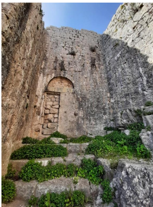
Slika 16 - Zazidani glavni ulaz izvana
