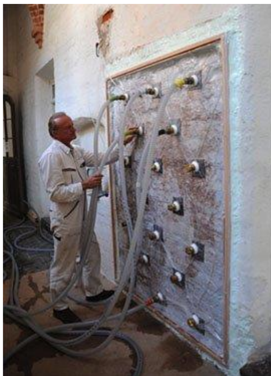
Slika 5. Prikaz procesa desalinizacije
