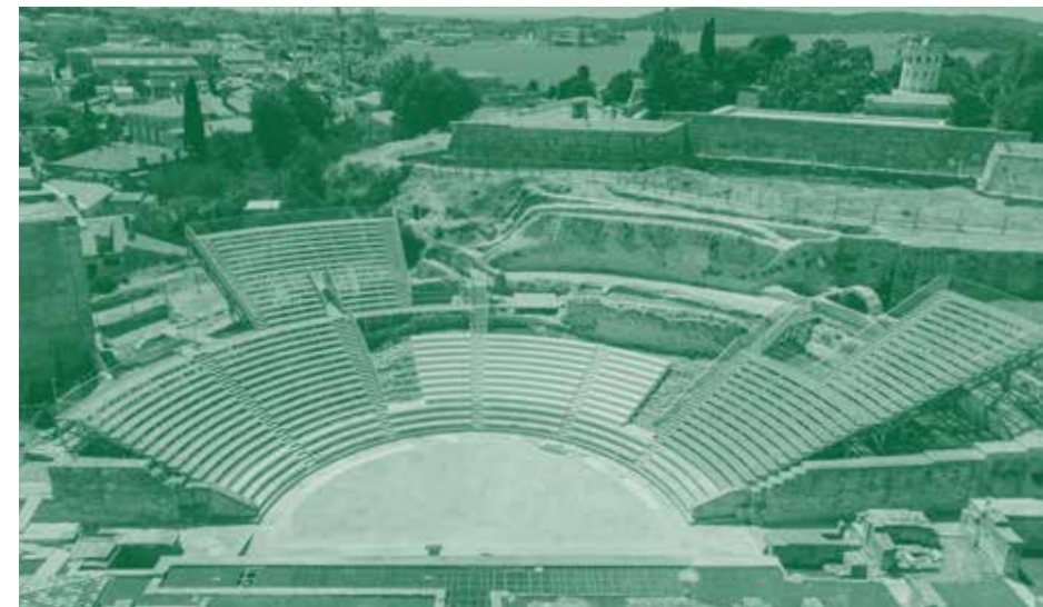
Slika 13 Renovirano Malo rimsko kazalište u Puli
