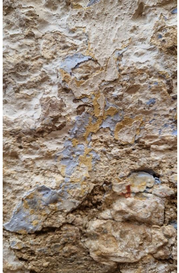
Slika 29, Detalj ostataka slojeva fasadnih boja na kamenoj fasadi kuće obitelji Dražojević-Jelić
