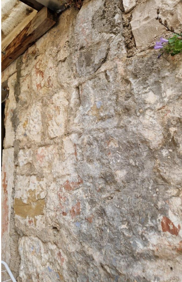
Slika 30, Detalj ostataka slojeva fasadnih boja na kamenoj fasadi kuće obitelji Dražojević-Jelić
