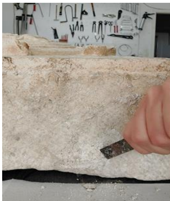
Slika 43, Mehaničko čišćenje ostataka žbuke sa bočnih strana
