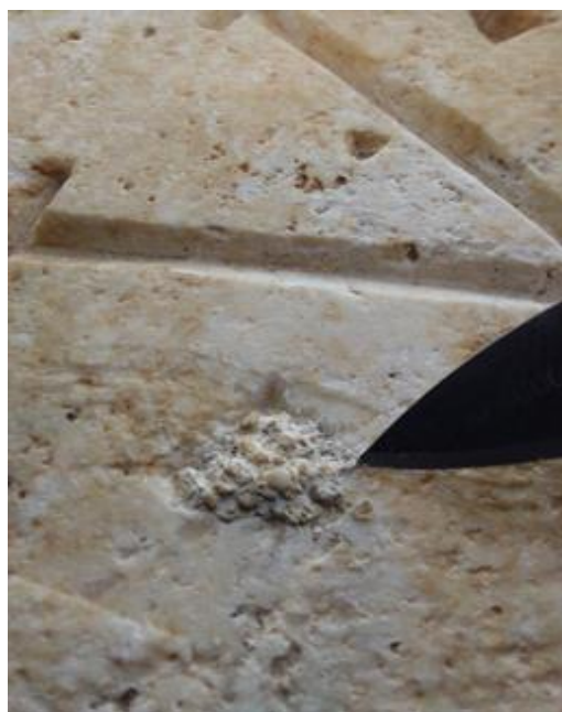
Slika 44, Mehaničko čišćenje ostataka žbuke
