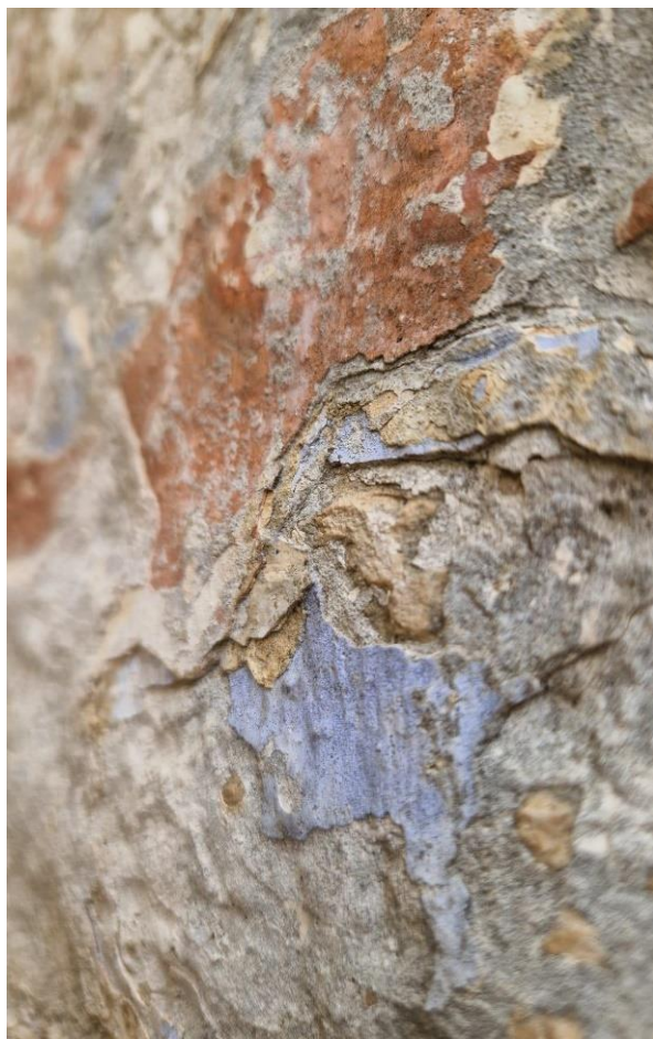
Slika 27, Detalj ostataka slojeva fasadnih boja na kamenoj fasadi kuće obitelji Dražojević-Jelić
