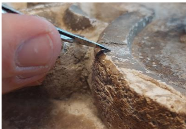
Slika 9, Mehaničko čišćenje skalpelom na mjestu sonde
