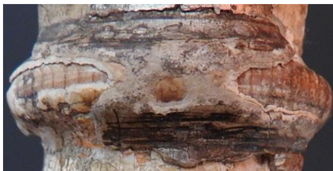
Slika 9. 1 Izraženi godovi drvenog nosioca
