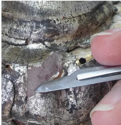
Slika 90. 2 Obrada rekonstrukcije u kitu
