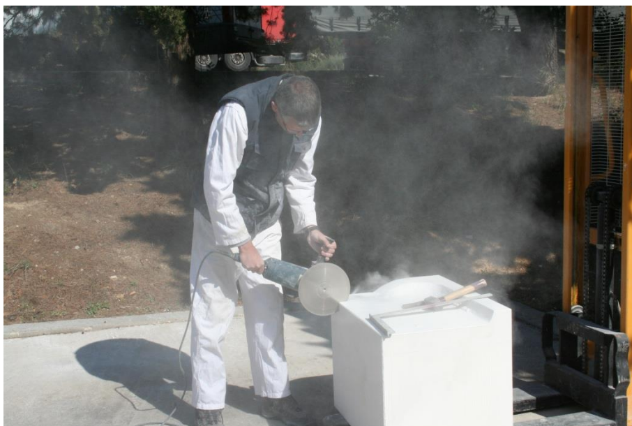
Slika 155. Zapilavanje prijelaza između prve i druge strane kamenog bloka, fotografija: Josipa Krolo
