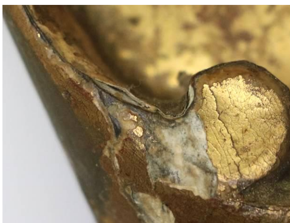
Slika 196 Detalj mjesta odvajanja preparacije od drvenog nositelja prije podljepljivanja
