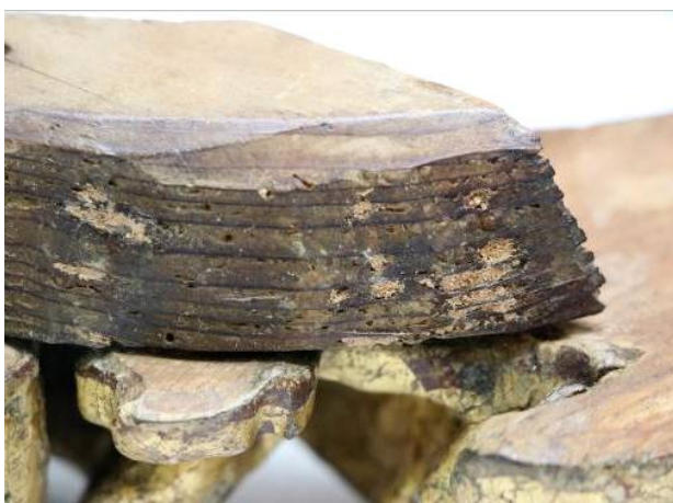
Slika 240 Ispunjena oštećenja na donjoj konstruktivnoj letvici
