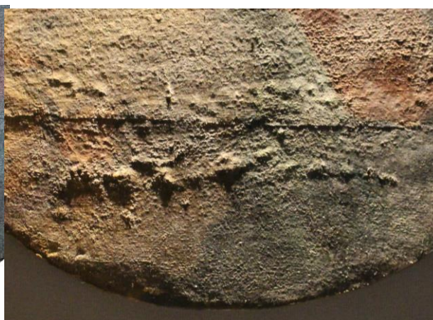
Slika 16 Konveksne deformacije šava pod bočnim svjetlom, detalj
