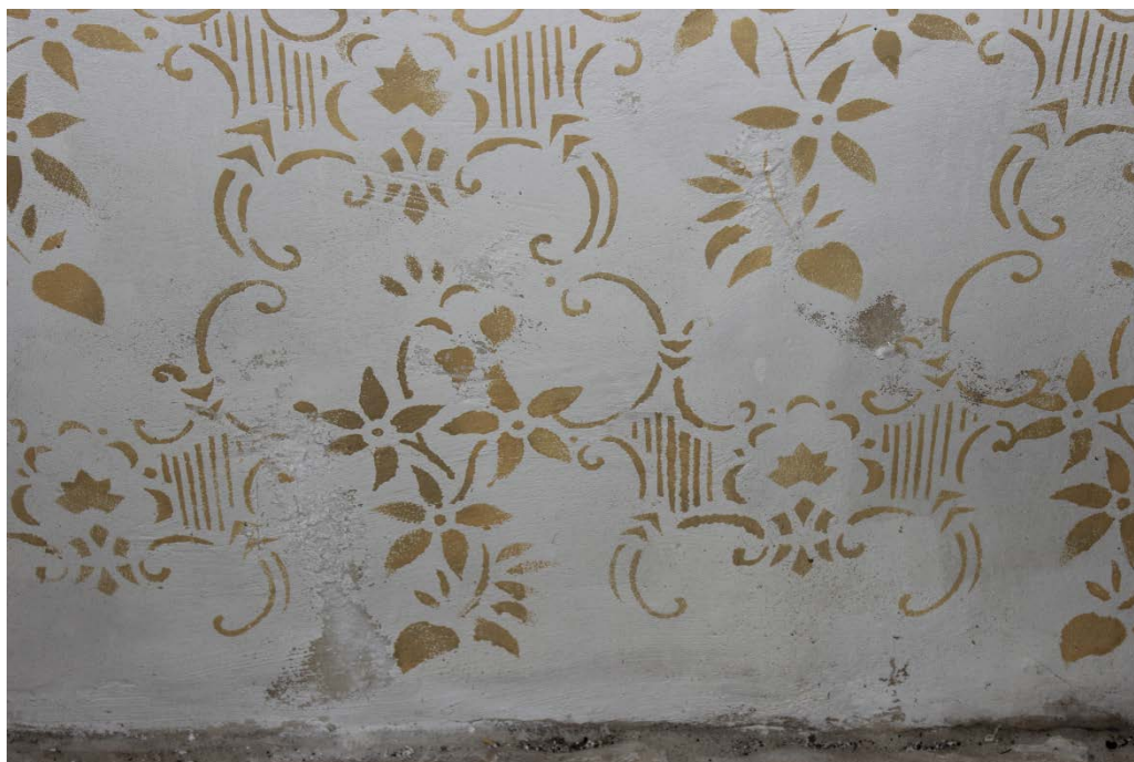
Slika 19. Područje cvjetanja soli i osipanja bojanog sloja (Nikolina Lovrić, 2018.)
