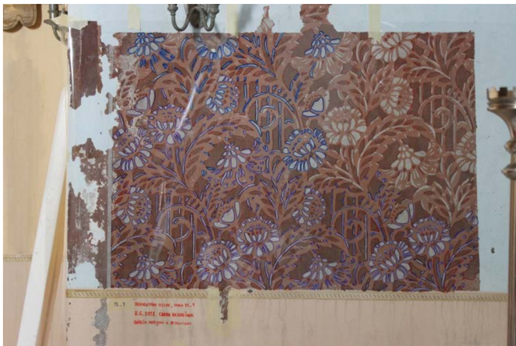
Slika 83. Prijenos dekorativnog zidnog oslika na melinex foliju. (Nikolina Lovrić, 2018.)
