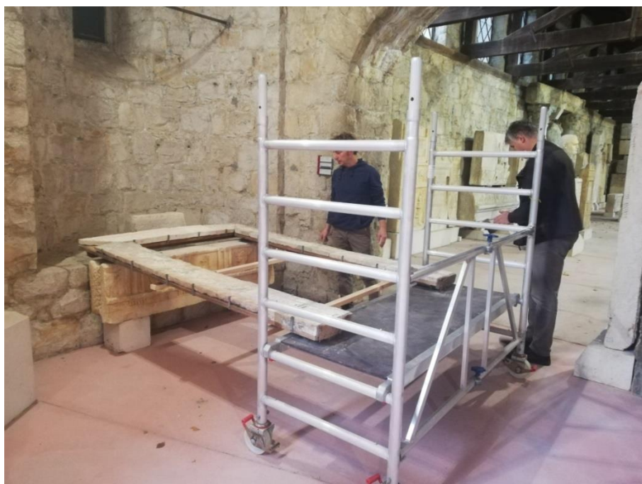
Slika 10: Demontaža mramorne oplate (foto: A. M. Lučić)
