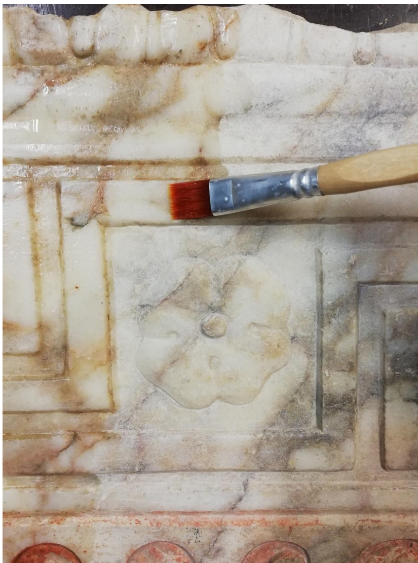
Slika 73: Detalj premazivanja površine mramora mikrokrystaličnim voskom (foto: A. M. Lučić)
