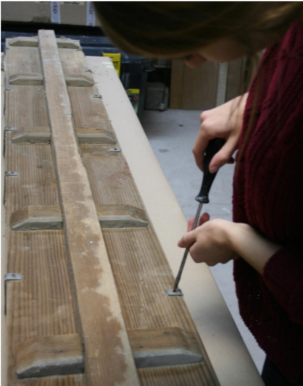
Slika 15: Odvajanje drvene nosive konstrukcije od mramorne oplata (foto: B. Pulić)
