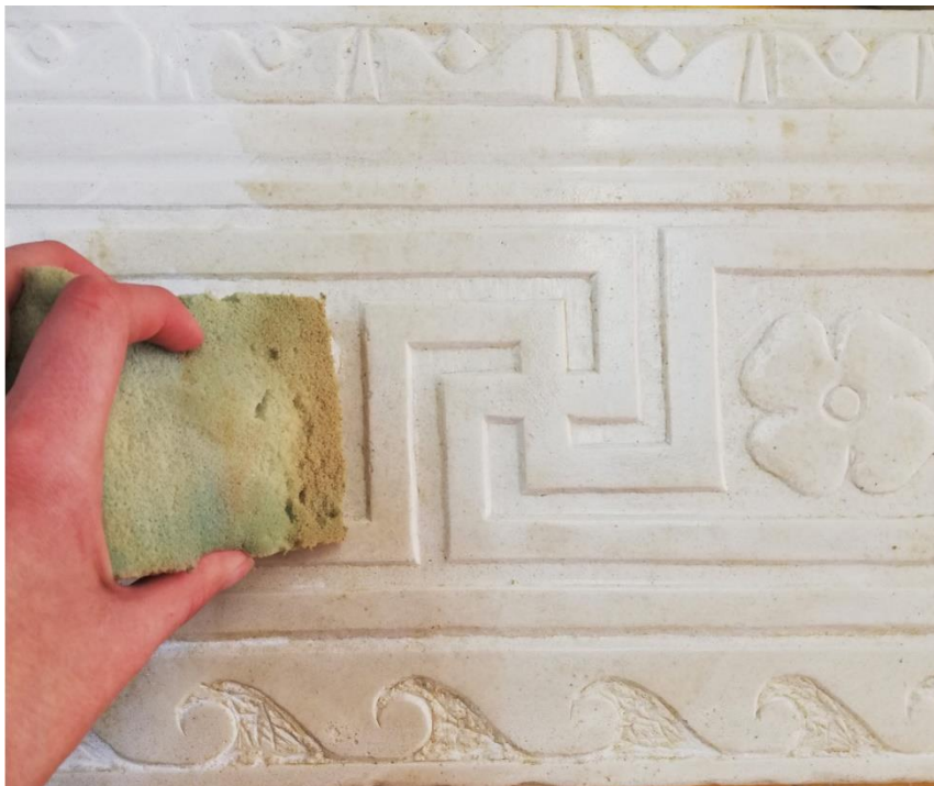
Slika 75: Toniranje rekonstrukcije (foto: A. M. Lučić)
