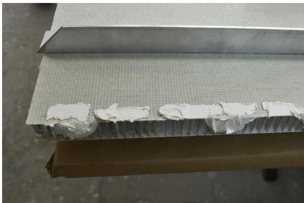
Slika 51: Lijepljenje lajsni (foto: A. M. Lučić)
