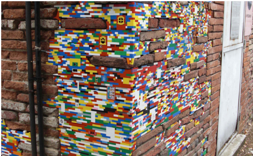
Slika 7. Dispatchwork – Popravljanje pukotina s Lego kockicama
