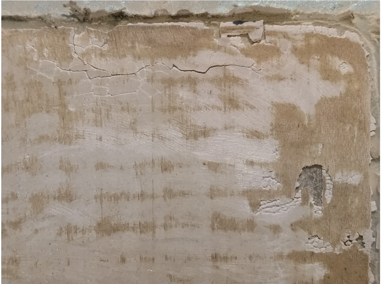
Slika 96 Oštećenja osnove prouzrokovana uklanjanjem drva pneumatskom brusilicom sa stožastim nastavkom
