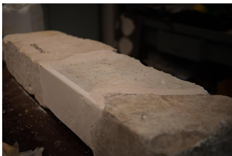
Slika 61 Popunjeni spojevi betonske rekonstrukcije s originalnim ulomcima s Acrystone smjesom (autor: Rina Dubravec)
