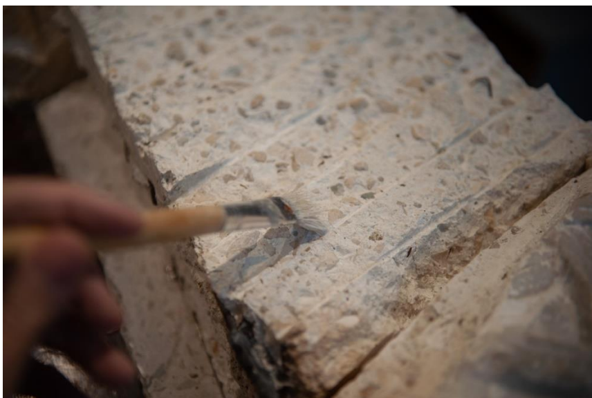
Slika 46 Premazivanje površine Sika Latexom (autor: Rina Dubravec)
