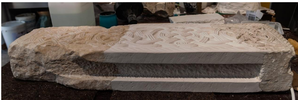
Slika 79 Pilastar nakon čišćenja suhim abrazivom pod tlakom (autor: Rina Dubravec)
