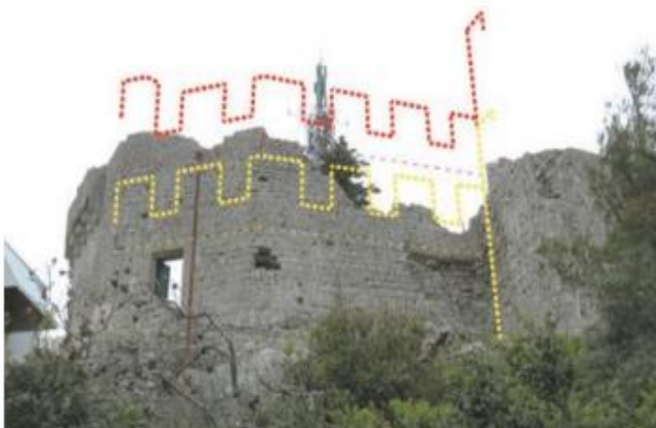
Slika 11 - Dvije faze obrambenog kruništa na jugoistoku kaštela
