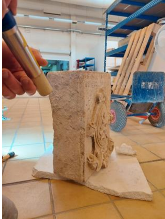
Slika 32, Lasersko čišćenje grba u Hrvatskom restauratorskom zaboru
