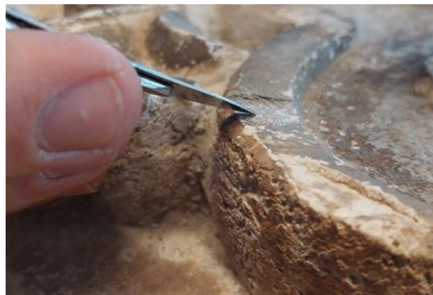
Slika 9, Mehaničko čišćenje skalpelom na mjestu sonde
