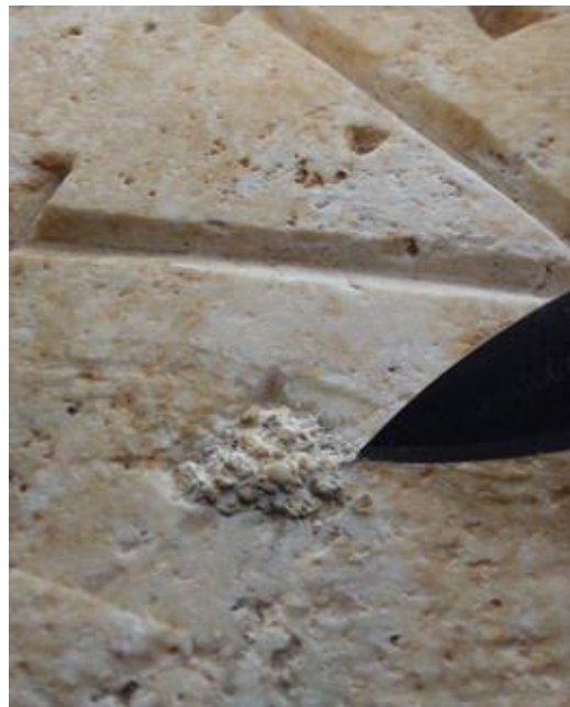
Slika 44, Mehaničko čišćenje ostataka žbuke
