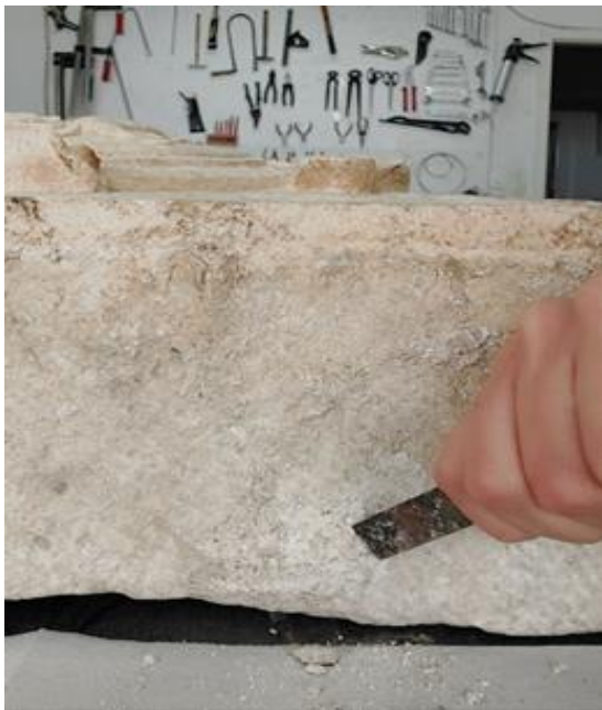
Slika 43, Mehaničko čišćenje ostataka žbuke sa bočnih strana
