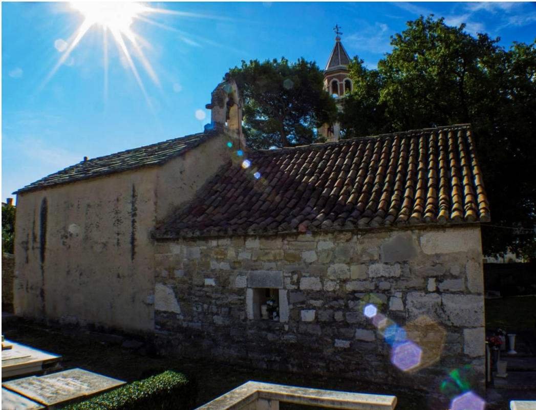
Slika27. Crkva sv. Kuzme i Damjana, pogled sasjeverozapada
