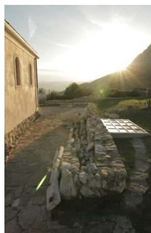
Slika 39. Cisterna C1 i kanal K1
