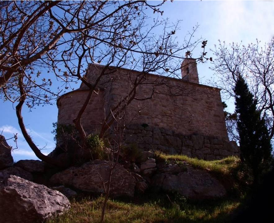
Slika 97. Sv. Mihovil, pogled s sjeveroistoka
