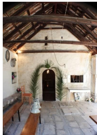
Slika 24. Ulaz u crkvu sv. Kuzme i Damjana, pogled sa zapada
