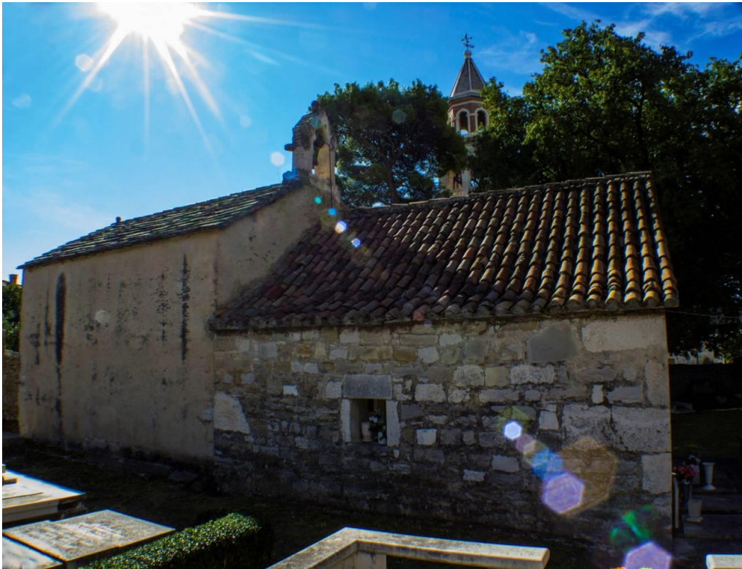
Slika27. Crkva sv. Kuzme i Damjana, pogled sasjeverozapada
