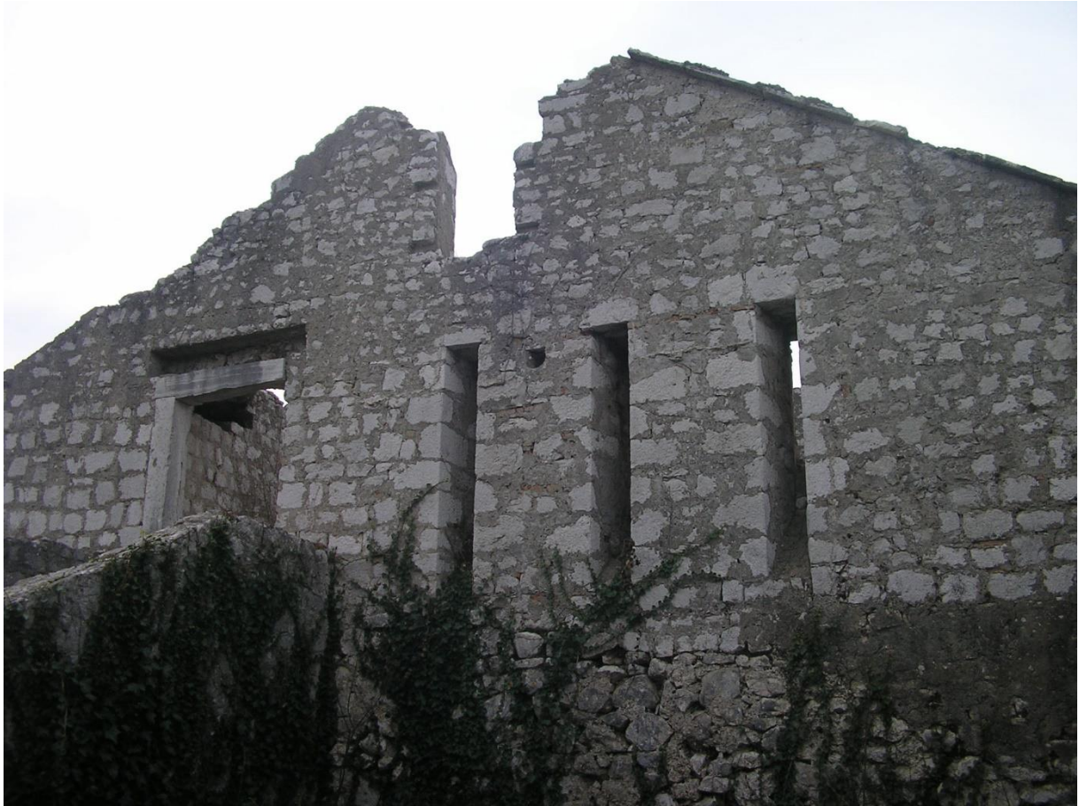
Slika 24. Ulaz u utvrdu Brštanić
