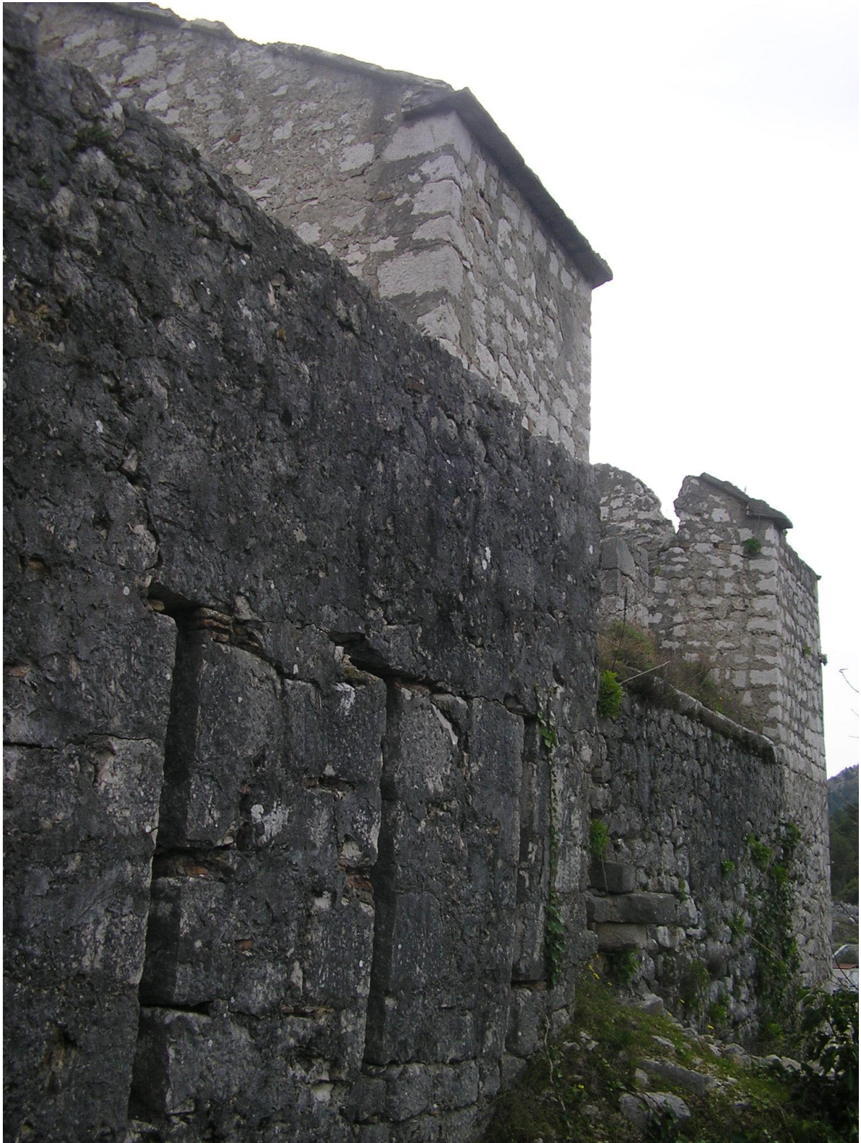
Slika 23. Vanjski zidovi utvrde Brštanik s otvorima
