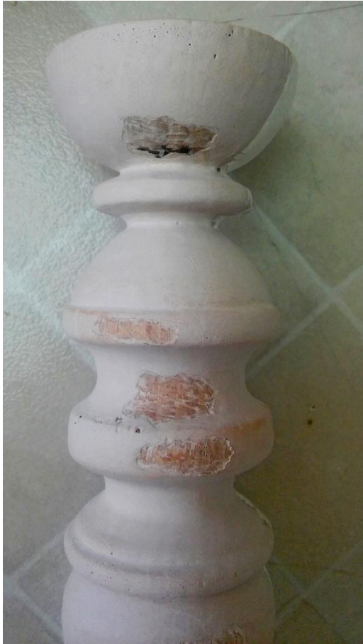
Slika 23. Detalj namjernih oštećenja
