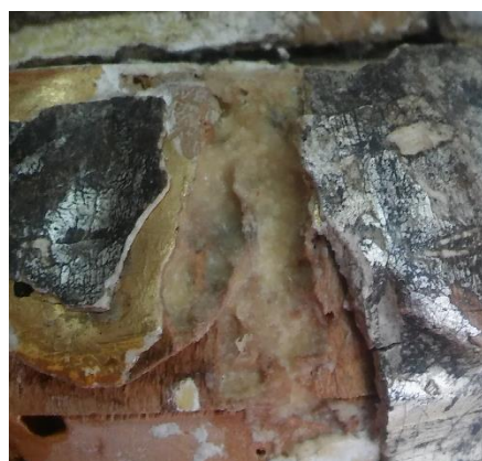
Slika 86. Kit na bazi Paraloida B72
