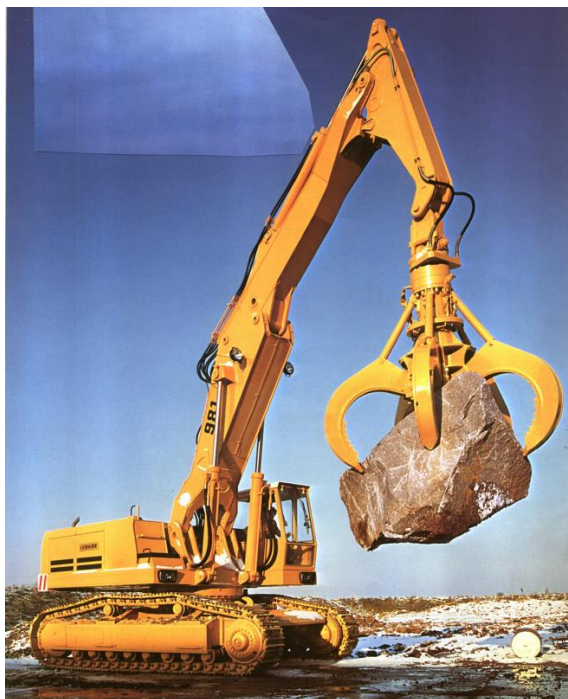
Sl. 36. Uporaba hidrauličnog bagera u kamenolomu
