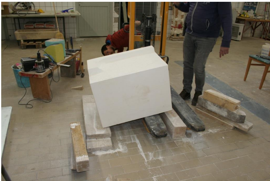
Slika 148. Postavljanje kamenog bloka u kosi položaj, fotografija: Josipa Krolo
