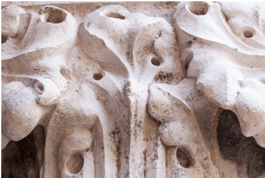
Sl. 100. Oblikovanje ravnim dlijetom, Velika Papalićeva palača, Split, 16. st., fotografija: Josipa Krolo
