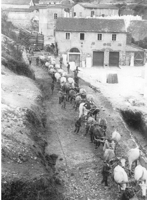
Sl. 28. Transport kamenih blokova volovskom zapregom, Carrara
