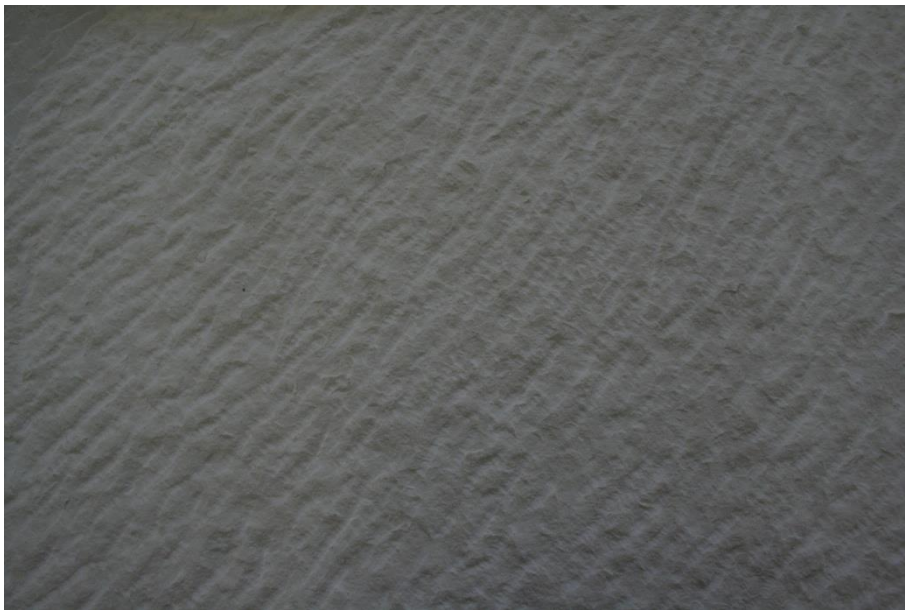
Slika 147. Gušći trag šiljastog dlijeta, fotografija: Josipa Krolo
