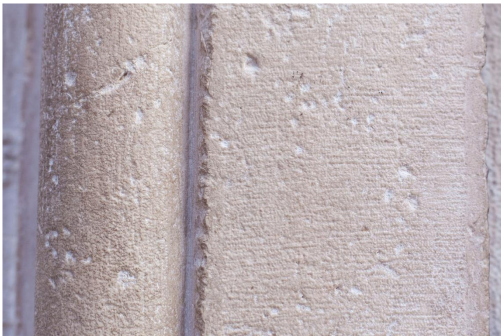
Sl. 113. Fina obrada martelinom, površina je erodirana, Velika Papalićeva palača, Split, 16. st., fotografija: Josipa Krolo
