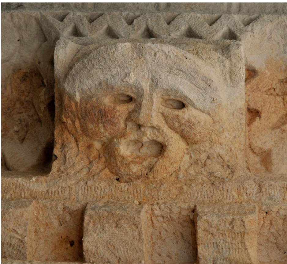
Sl. 96. Lice figure i denti obradene gradinom, Peristil, fotografija: Vinka Marinković
