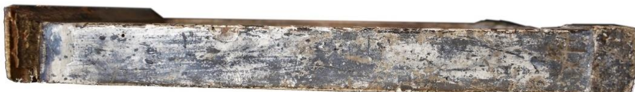
Slika 33 Desni okvir, zatečeno stanje, preslik
