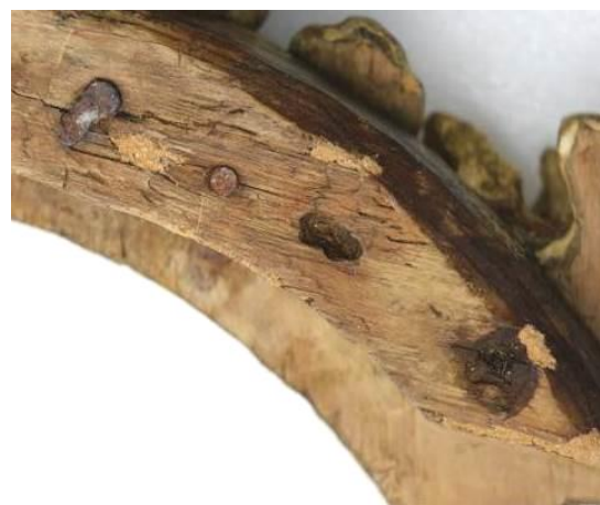
Slika 241 Ispunjena oštećenja u gornjoj konstruktivnoj letvici
