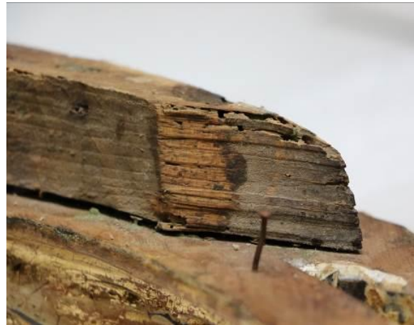
Slika 232 Detalj bočne strane konstruktivne letvice tijekom čišćenja Absorene spužvicom namočenom toplom vodom
