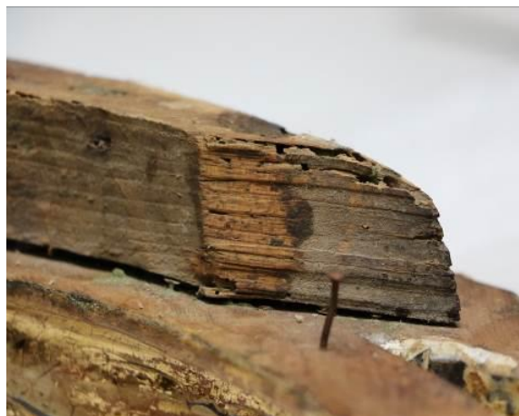
Slika 232 Detalj bočne strane konstruktivne letvice tijekom čišćenja Absorene spužvicom namočenom toplom vodom
