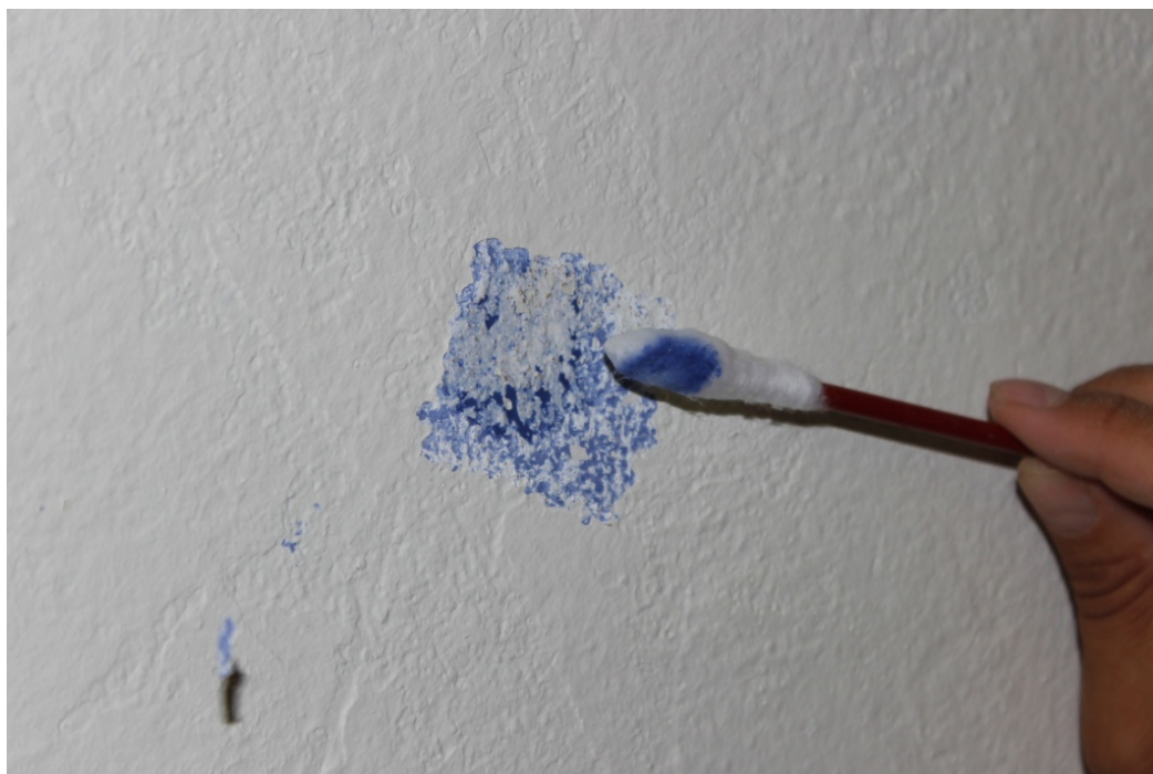
Slika 59. Uklanjanje preslika uz pomoć tamponića s vodom. (Nikolina Lovrić, 2018.)
