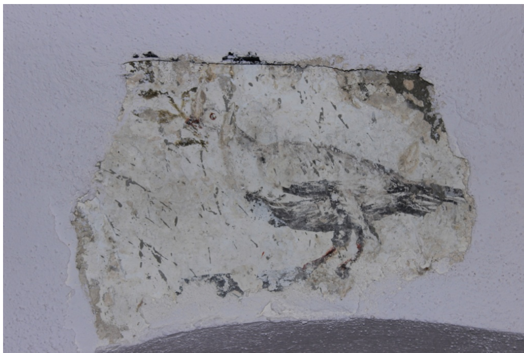
Slika 36. Sonda u sjevernom zidu broda crkve sv. Klementa. (Nikolina Lovrić, 2018.)
