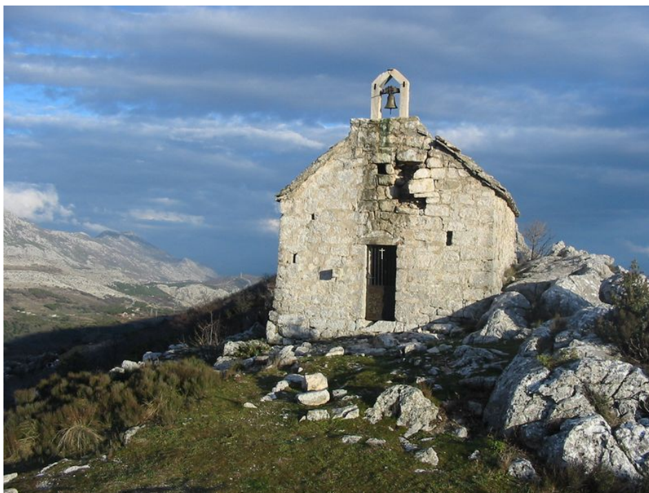
Slika 47 Crkva svetog Maksima u Jesenicama prije obnove. Preuzeto sa: https://smn.hr/jesenice (pristupljeno 29.1.2019.)
