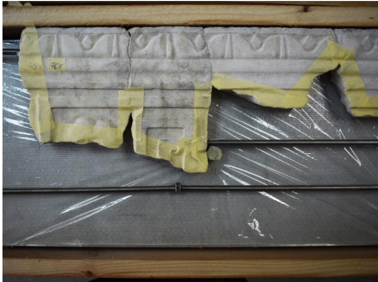
Slika 62: Detalj pripremljene podloge za lijevanje umjetnoga kamena (foto: A. M. Lučić)
