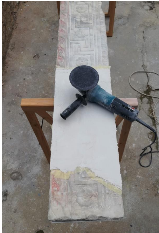
Slika 63: Brušenje Acrystala (foto: A. M. Lučić)
