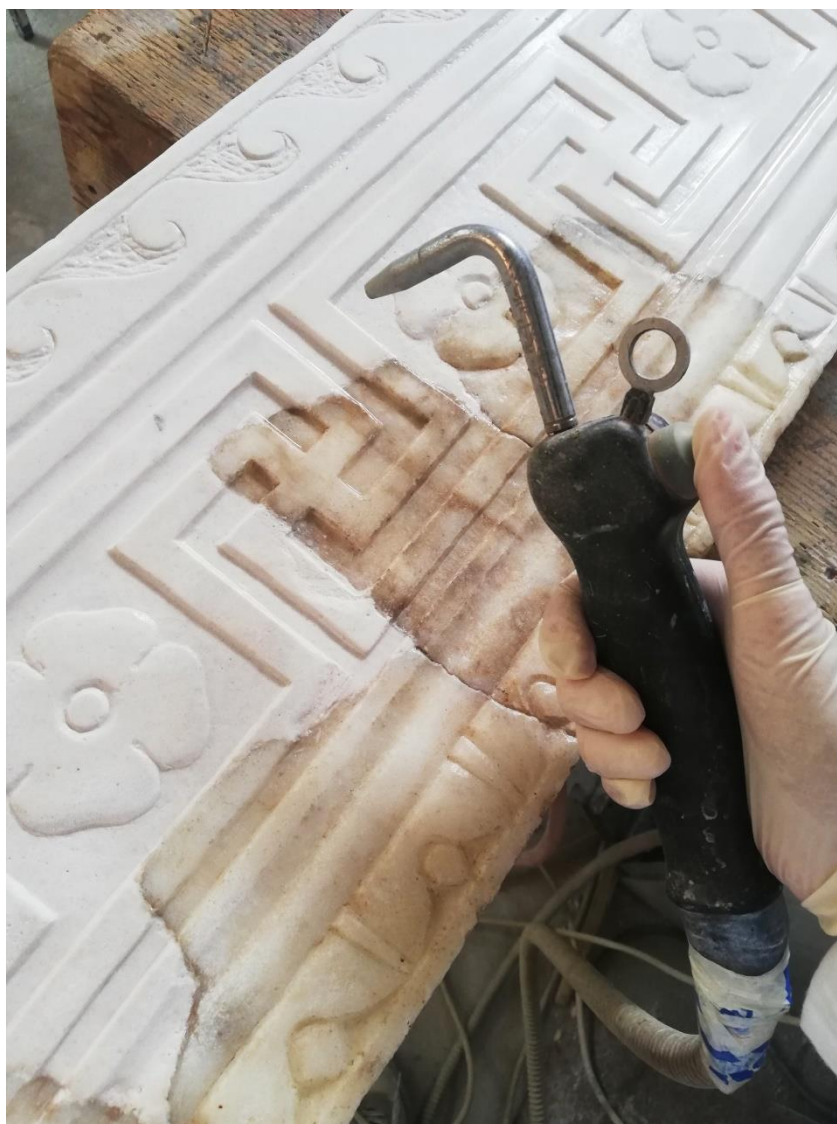
Slika 71: Završno čišćenje mramorne oplate (foto: A. M. Lučić)
