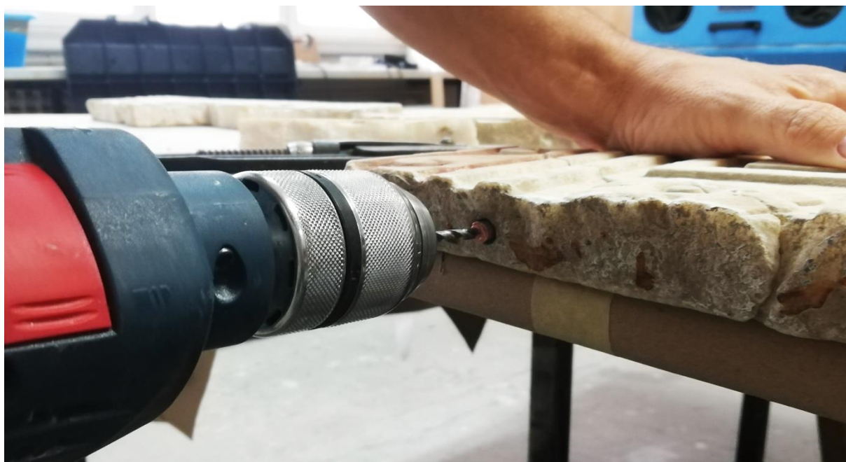
Slika 21: Vađenje brončanog trna (foto: A. M. Lučić)
