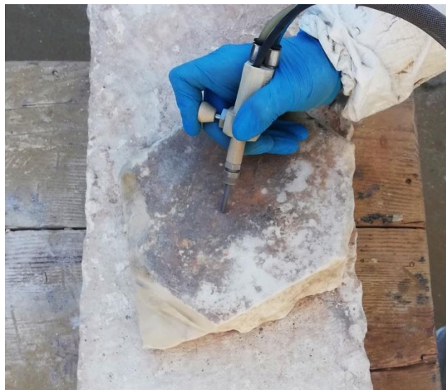
Slika 28: Abrazivno čišćenje (foto: A. M. Lučić)
