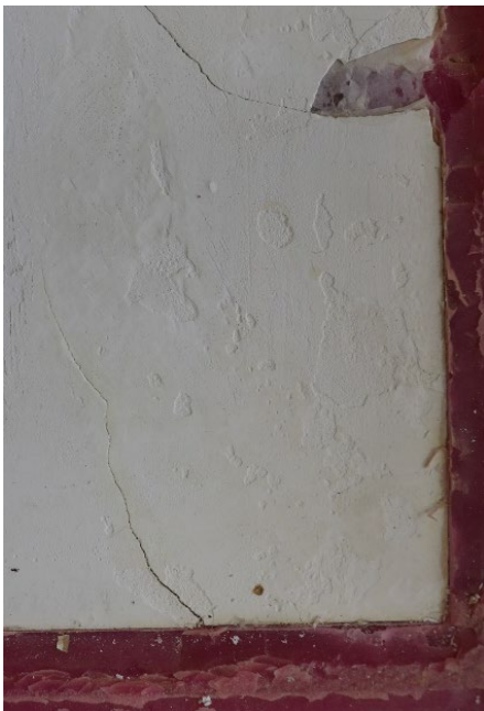
Slika 41 Prije kitiranja osnove
