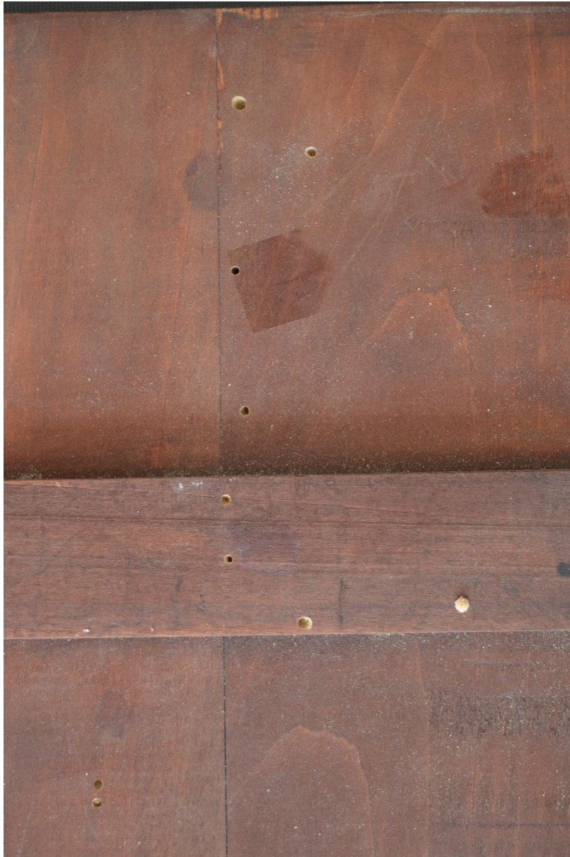
Slika 4 Detalj izlaznih rupica crvotočine
