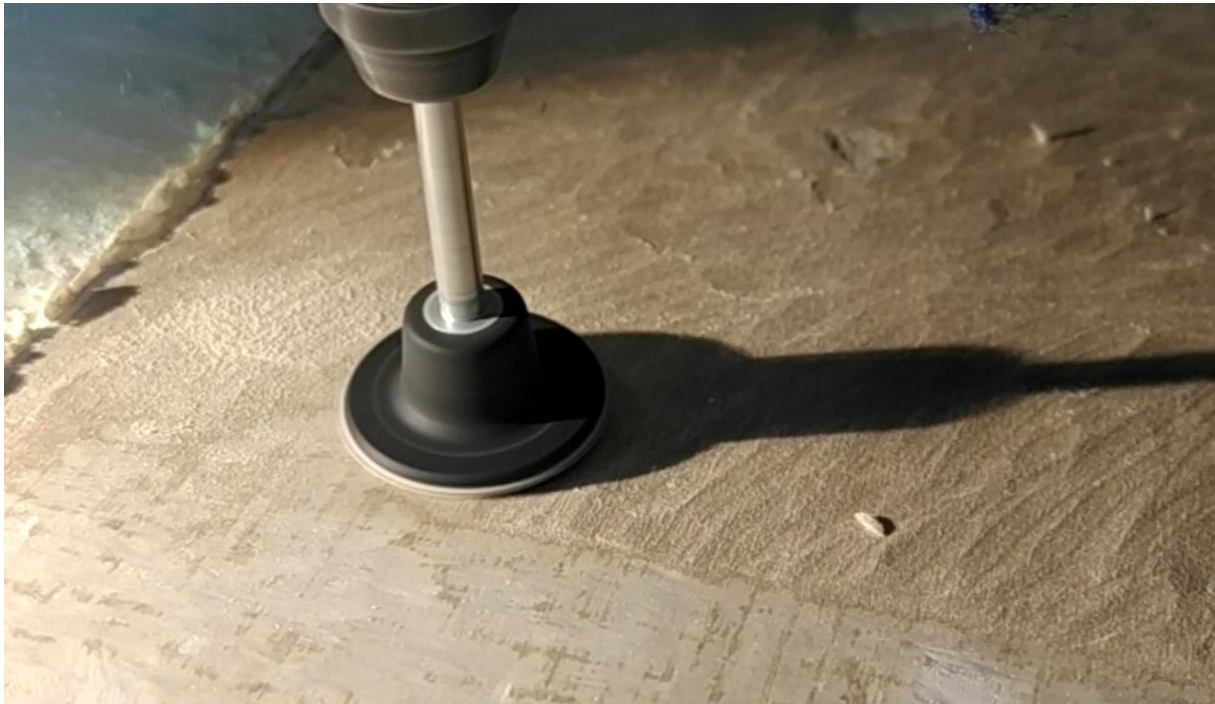
Slika 99 Uklanjanje posljednjeg sloja drva s pneumatskom brusilicom s nastavkom tanjurastog oblika
