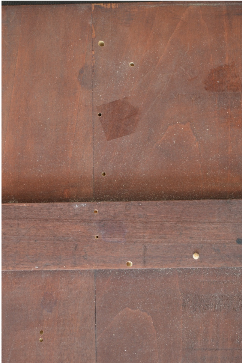
Slika 4 Detalj izlaznih rupica crvotočine
