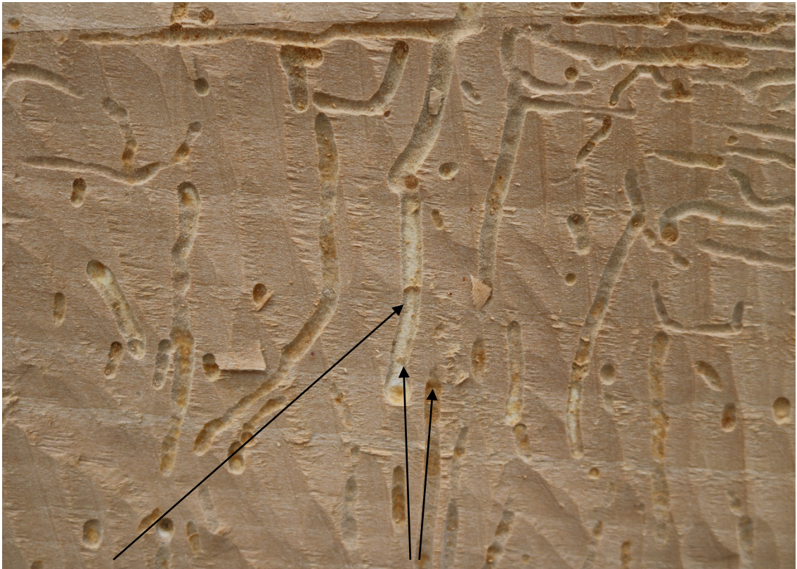
Slika 36 Detalj kanalića crvotočine
