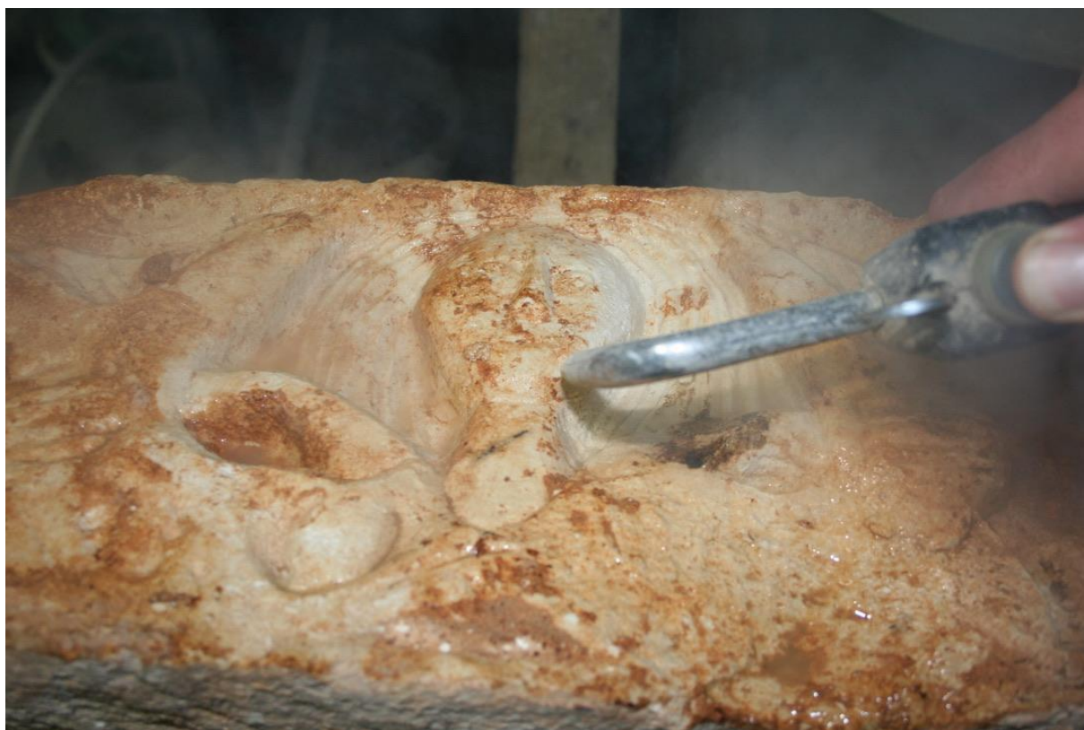
Slika 81. Čišćenje vodenom parom, fotografija: Martin Zohil
