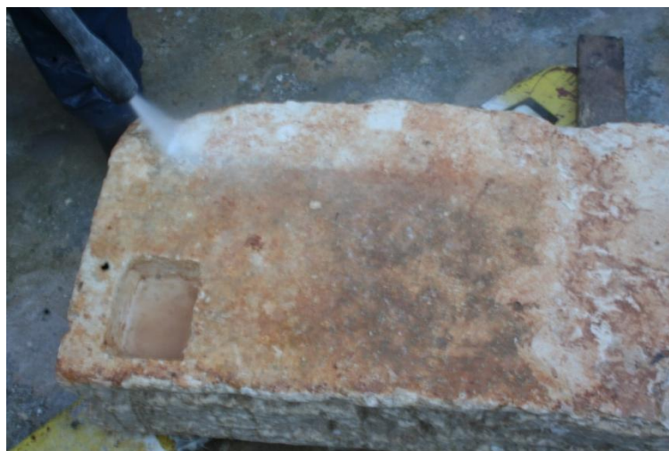
Slika 83. Čišćenje miniwashom, fotografija: Martin Zohil
