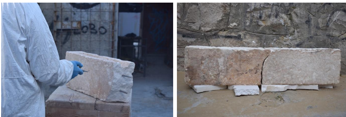
Slika 44 i 40. Mikropjeskarenje, fotografija: Martin Zohil
