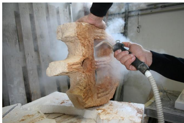
Slika 21. Čišćenje vodenom parom, fotografija: Martin Zohil
