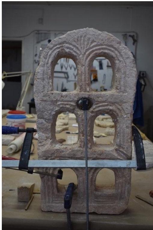
Slika 25. Spojena tranzena, fotografija: Martin Zohil
