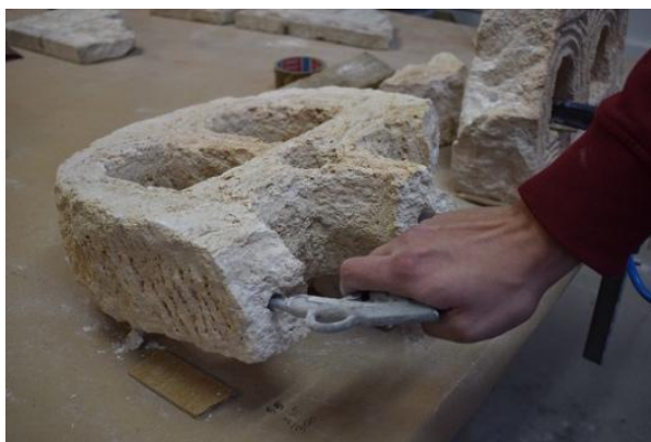
Slika 23. Ispuhivanje rupa, fotografija: Martin Zohil
