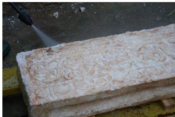
Slika 63. Čišćenje miniwashom, fotografija: Martin Zohil
