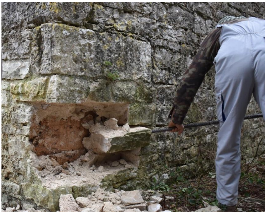
Slika 128. Razgradnja zidane pozicije – za ugradnju replike ulomaka nepoznate namjene, fotografija: Martin Zohil
