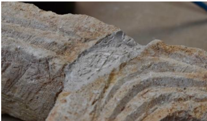
Slika 26. Proces nanosa rekonstrukcije, fotografija: Martin Zohil
