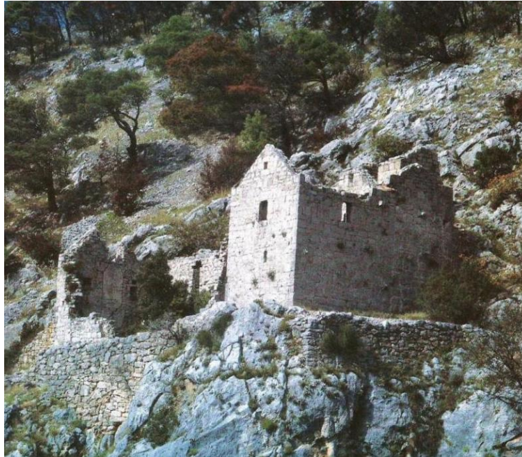
Sl. 35. Ruševine zgrade samostana picokara Silvio danas
