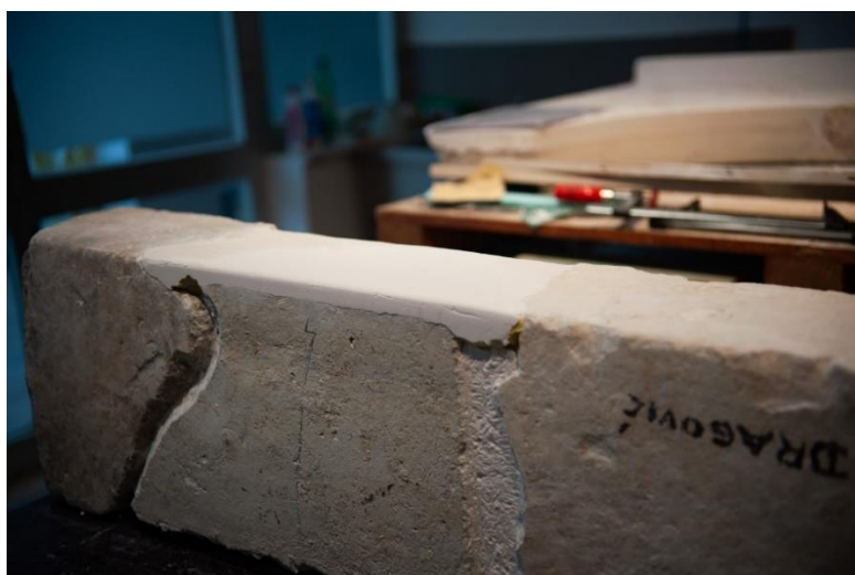
Slika 60 Osušena Acrystone smjesa na vanjskoj bočnoj strani pilastra (autor: Rina Dubravec)
