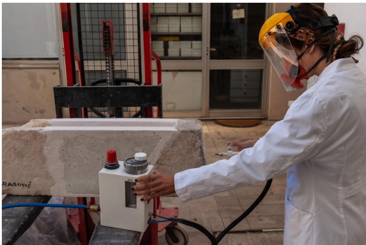
Slika 78 Čišćenje površine suhim abrazivom pod tlakom (autor: Mladen Matijaca)
