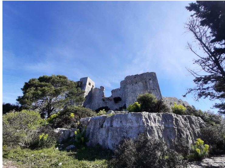
Slika 13 - Pogled izvana na jugozapadni dio utvrde sa branič kulama i zazidanim ulazom
