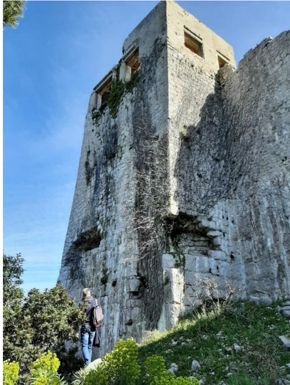
Slika 22 - Pogled izvana na jugozapadnu kulu
