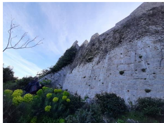
Slika 9 - Pogled izvana na zidine utvrde sa zapada
