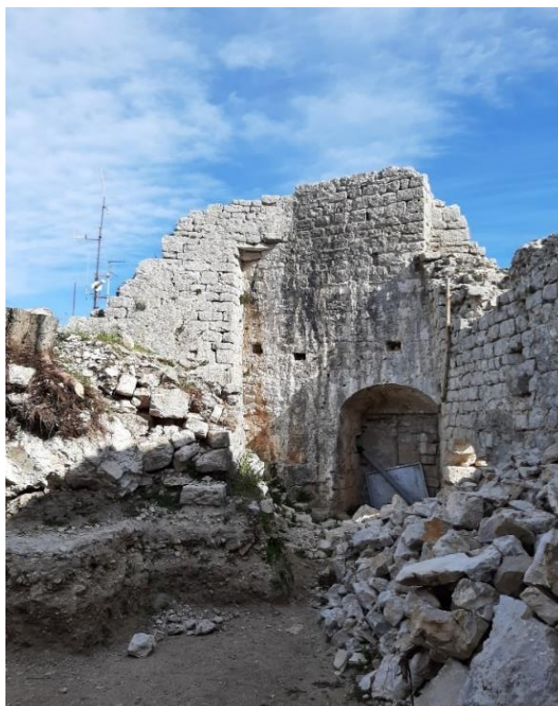
Slika 14 - Pogled iznutra na donžon i zazidani glavni ulaz
