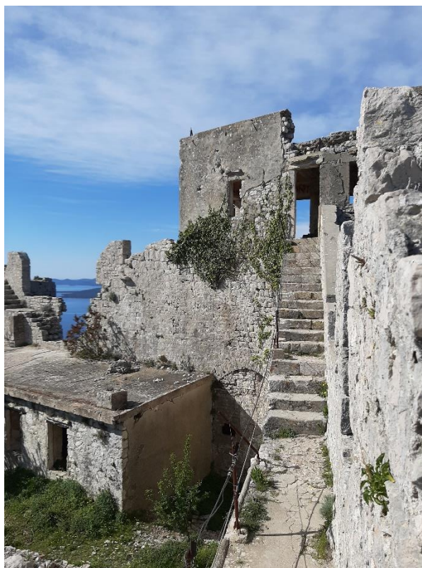
Slika 24 - Stepenice koje vode na jugozapadnu kulu i dogradnju iz 20.st..
