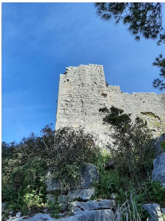
Slika 19 - Pogled izvana s istoka na jugoistočnu kulu
