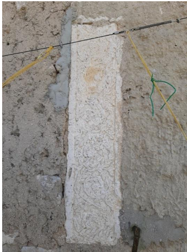
Slika 1 - Ostatci kamene plastike iz crkve uzidani u zgradu koja se do nedavno koristila za potrebe održavanja TV i radio odašiljača
