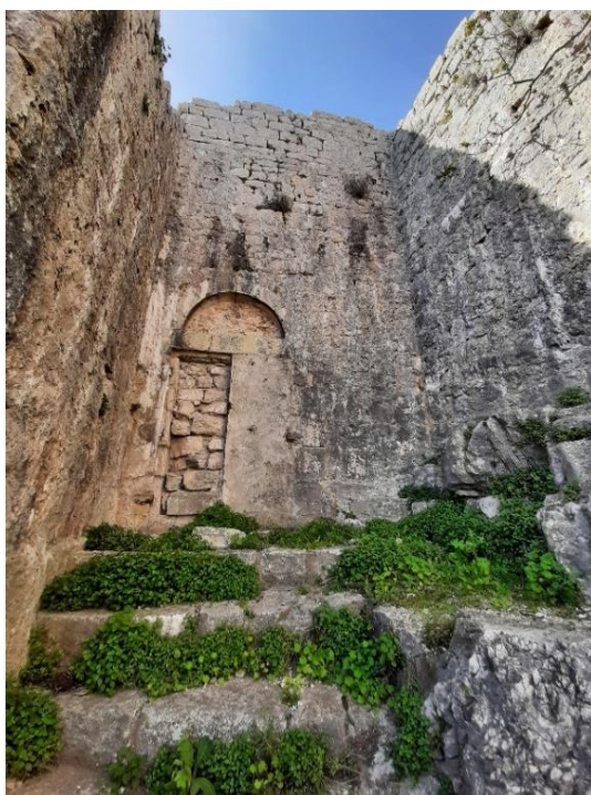
Slika 16 - Zazidani glavni ulaz izvana
