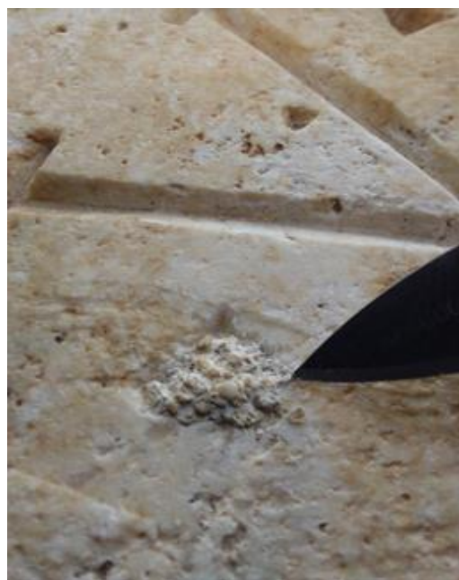
Slika 44, Mehaničko čišćenje ostataka žbuke
