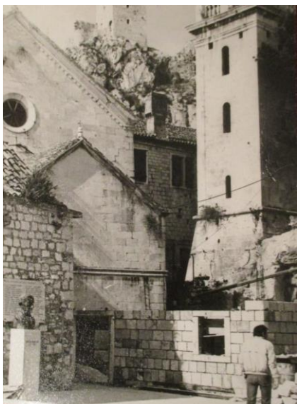
Slika 23, Ponovna izgradnja obiteljske kuće Dražojević-Jelić
