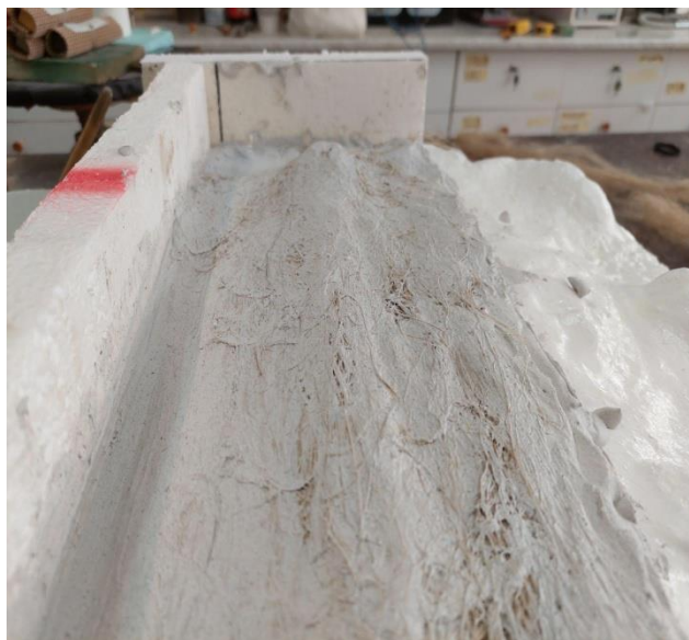
Slika 38, Nanošenje gipsa sa dodatkom kudelje i drvene letve kao armatura
