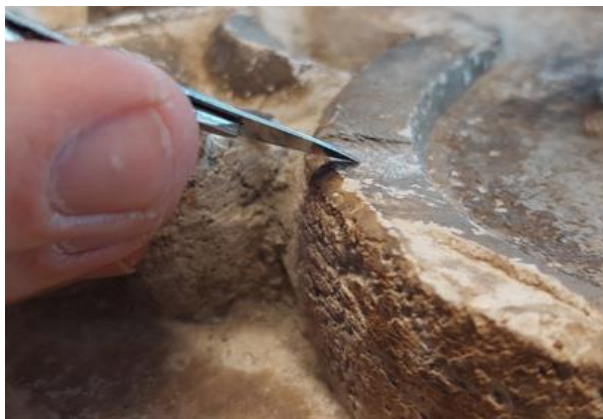
Slika 9, Mehaničko čišćenje skalpelom na mjestu sonde
